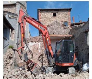
Déblaiement des murs et charpentes détruits par le feu
