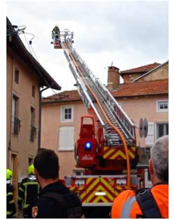
Les pompiers ont dû déployer la grande échelle
